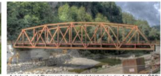
Achslast- und Rissmonitoring Kugelsteinbrücke (im Auftrag der ÖBB) (im Auftrag der TU Graz und der ÖBB, 2015 - 2016)
