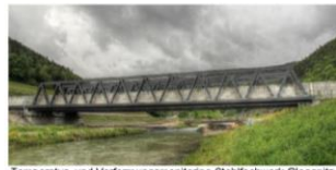
Temperatur- und Verformungsmonitoring Stahlfachwerk Gloggnitz (im Auftrag der ÖBB, 2014 - 2016)
